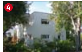
4 Helgamagrastræti 1-13 a. 1935. b. Þórir Baldvinsson. c. Ein af fyrstu íbúðarhúsum á Akureyri byggð í fúnkisstíl. Húsin eru reist fyrir Byggingarsamvinnufélagið á Akureyri.
