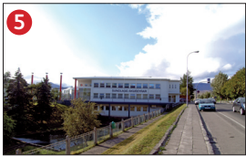
Sundlaug Akureyrar a. 1949, 1997-2006. b. Guðjón Samúelsson / Bárður Ísleifsson. Viðbygging: Form. c. Viðbyggingin fékk 1. verðlaun í lokaðri samkeppni.
