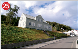
Hafnarstræti 49 a. 1895. b. Byggt fyrir Pál Briem amtmann. c. Stóð við byggingu utan bæjarmarka Akureyrar.
