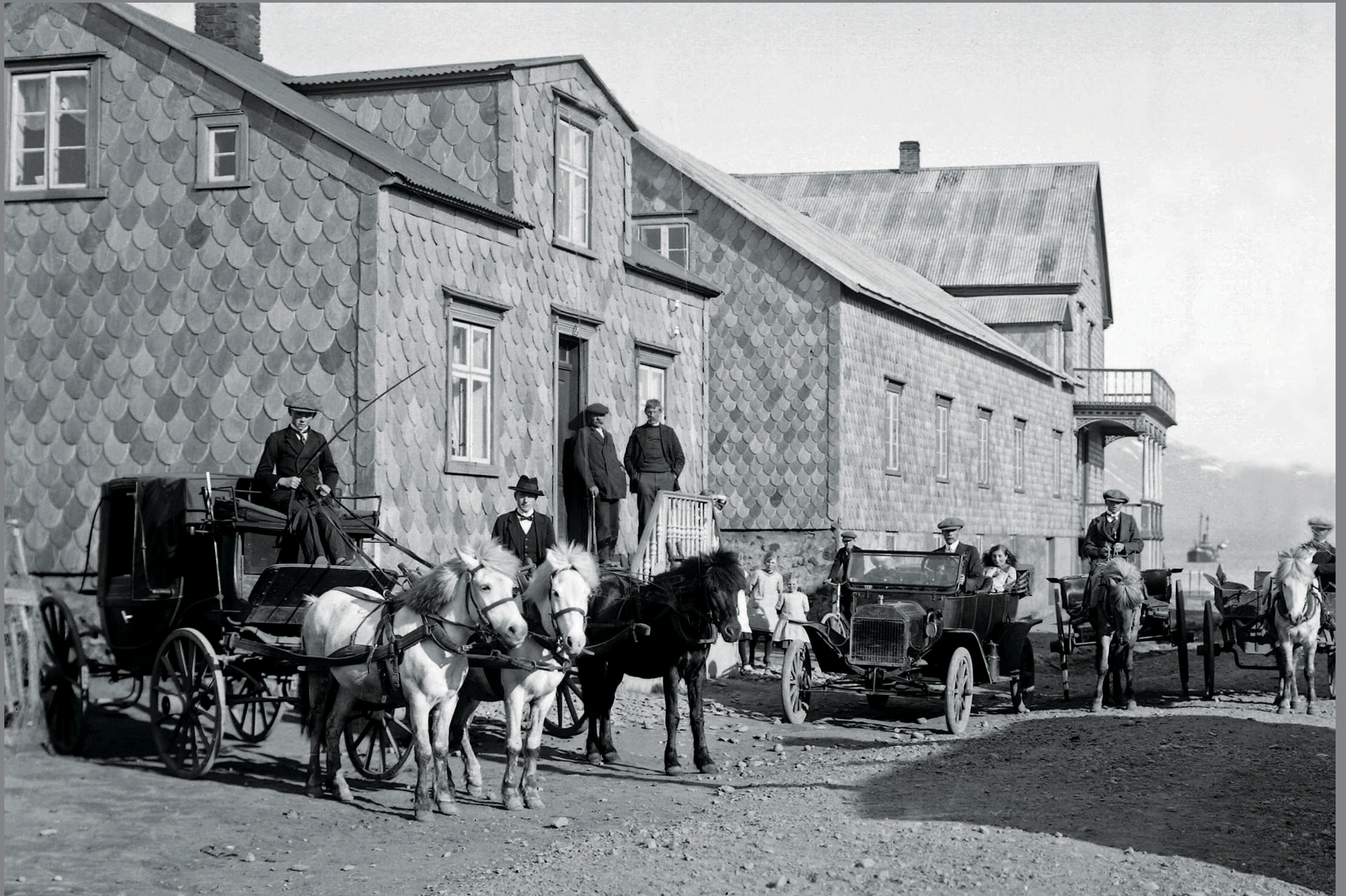
Norðurgata um 1915. Snorri Jónsson, timburmeistari og kaupmaður, byggði 1897 stórhúsi við Strandgötu 29 (húsið fjær á myndinni). Snorrahús var rífið 1987. Húsið nær á myndinni er Norðurgata 2 sem enn stendur. Bæði húsin eru klædd steinskífum. Bifreiðin er af Fordgerð, eign Soffoníasar Baldvínssonar, sem tók bílpróf fyrstur Akureyringa.
